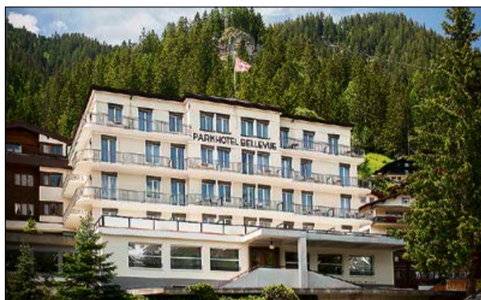
Für den Umbau wurde die ganze Südseite des Hotels ausgehöhlt.
